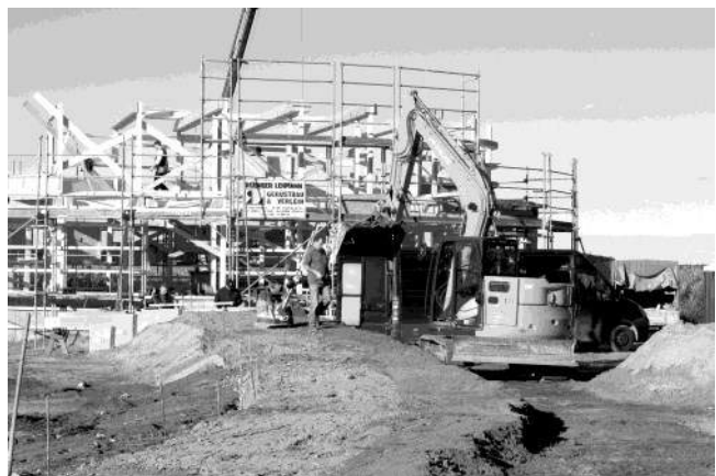
Abb. 3: Hochbauarbeiten am KRANORAMA (Foto: Günter Nowald).
